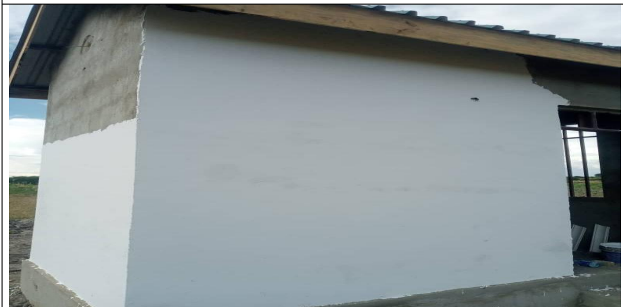
Ujenzi wa kibanda cha umeme Bahi
