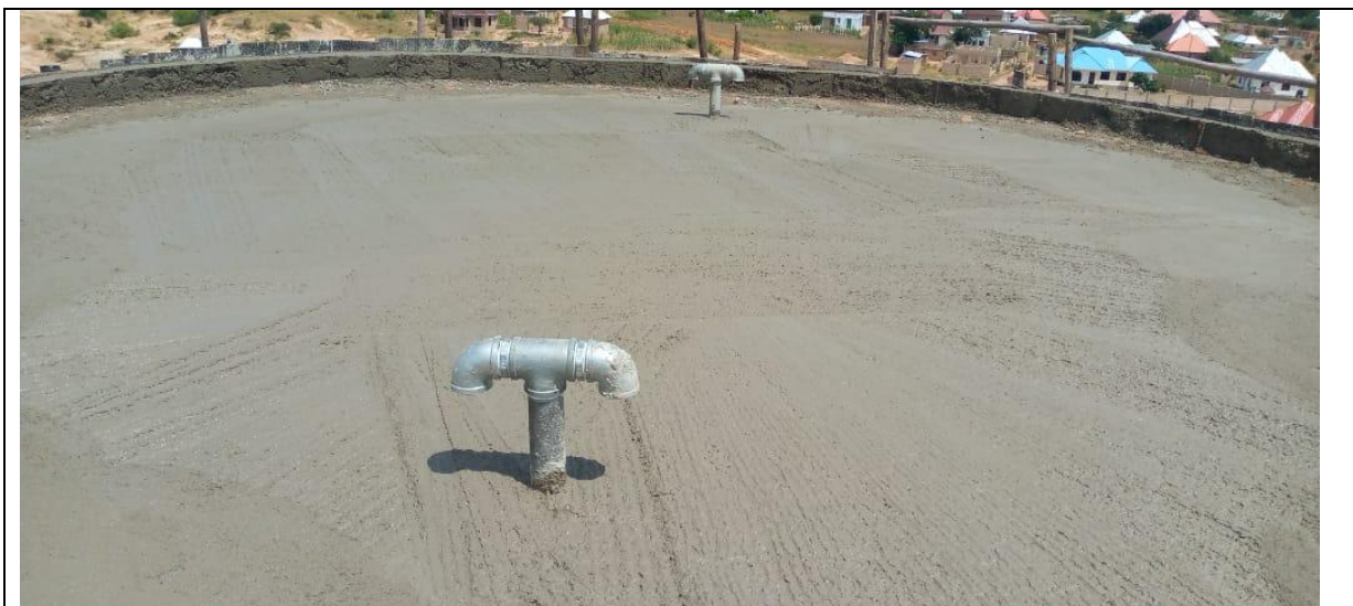
Ujenzi wa mfuniko wa tanki la Ntyuka
